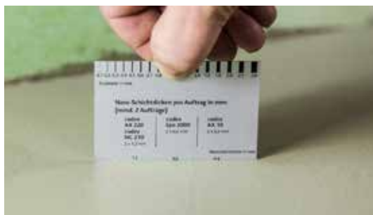
2. Nejprve se připraví kontaktní vrstva a pak se 4 mm ozubenou stěrkou připraví vlastní vrstva. Hladkou stranou se izolace uhladí. Po zaschnutí se připraví druhá vrstva.
