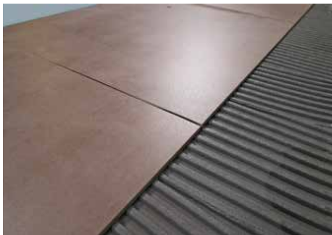
Dlažbu položenou s codex Power RX 11 Outdoor lze spárovat již po 6 hodinách.
