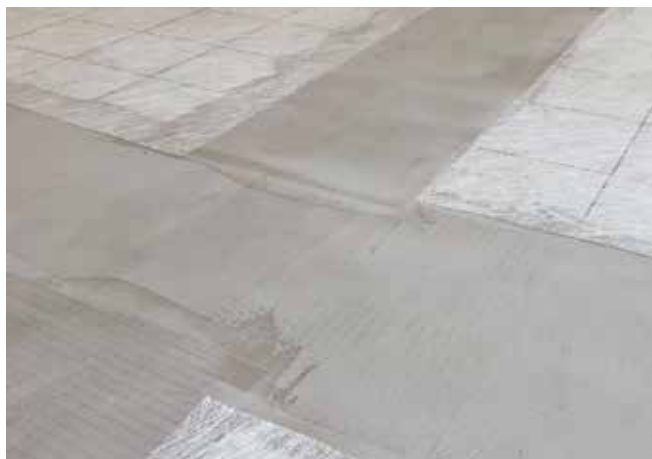
Před vyplněním RR 203 pomocí RX 6 Turbo vyplňte sloty pomocí EX 24.
