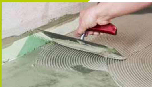
1. AX 230 se rozleje do koutu a rovnoměrně rozprostře po podkladu
