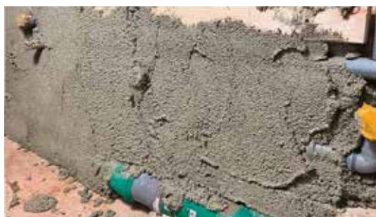
Uzavření kabelových kanálů a zasypání instalačních úrovní, 15 cm v jednom kroku
