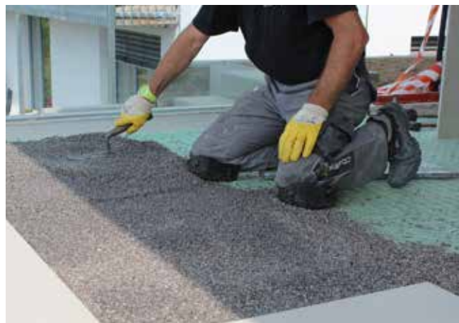
Vmíchejte codex ER 100 s codex DS 3/5 a vytvořte drenážní maltu. Instalace malty a vyrovnejte. Obklady a dlažby pokládejte pomocí lepidla codex SX 80 Cristal.
