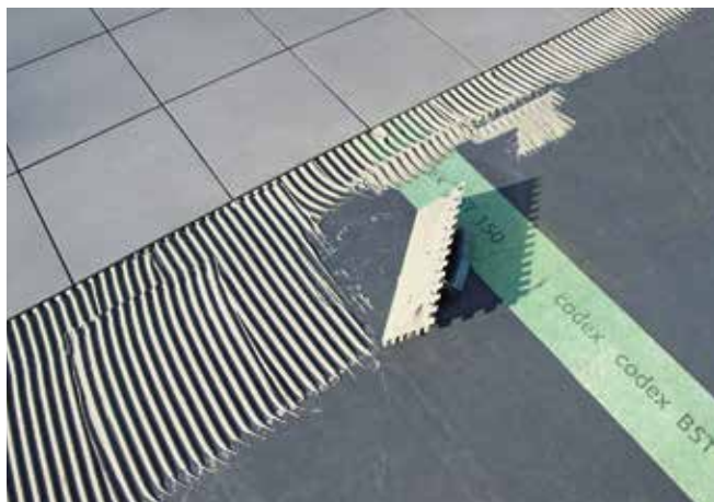
codex BalkuSlim® se instaluje pomocí systémových komponent UZIN RR 185 a codex BST 150.
