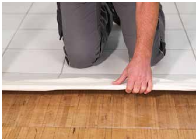
Vložte rouno X-Change do mokré fixace. Po 24 hodinách, aplikujte obklady a dlažby a přírodní kámen vhodným lepidlem Codex.
