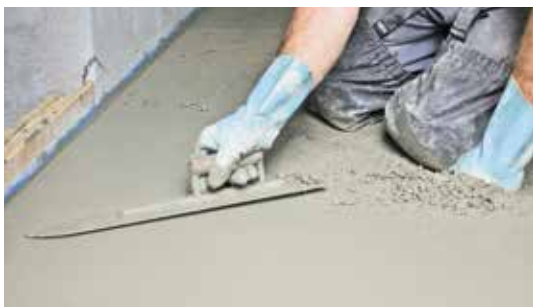
Vyhladejte povrch potěru hladítkem.
