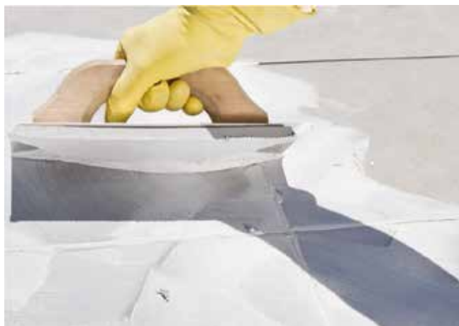
Spárování pomocí codex X-Fusion
