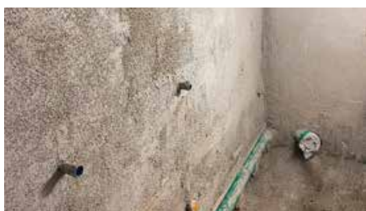
Hotová omítnutá stěna s FM 388 Light před aplikací tkaninového plniva codex UX 410 a tenkovrstvé malty codex.
