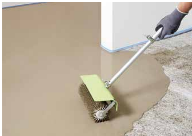
Nanesení vyrovnávací hmoty codex FM 50 Turbo na sanační rouno UZIN RR 201.
