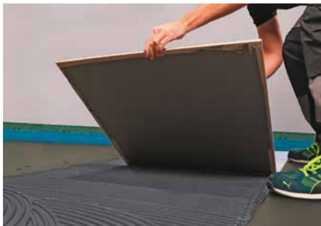
Pro lepší přilnavost při instalaci použijte metodu oboustranného nanášení lepidla
