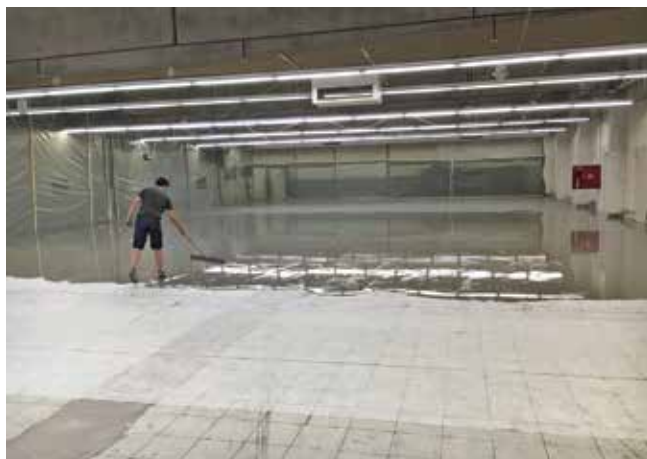
Naneste samonivelační cementovou vyrovnávací hmotu FM 50 Turbo.
