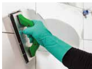
3. codex X-Fusion se snadno zpracovává - jako cementové spárovací hmoty
