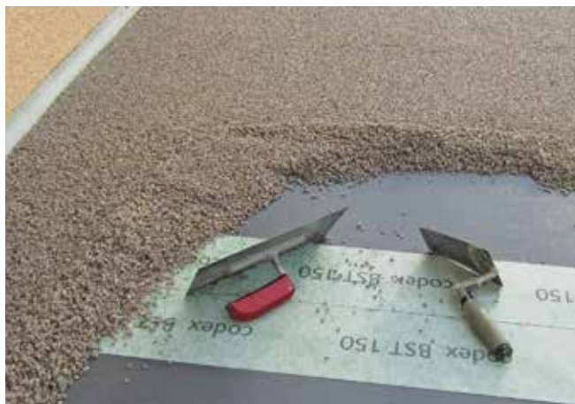
codex BalkuDrain® instalovaný pomocí systémových komponent UZIN RR 185 a codex BST 150.
