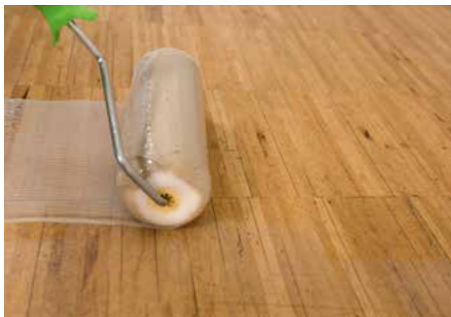
Na připravený podklad naneste fixaci X-Change
