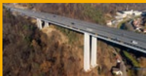
SANACE A OCHRANA KONSTRUKCÍ
