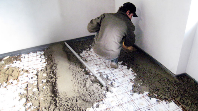
Provádění cementových potěrů
