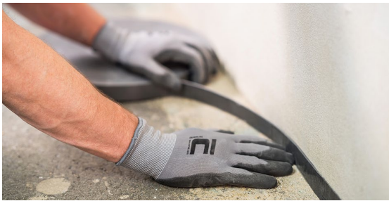
Obvodový dilatační pásek spolehlivě utěsní obvod a zajistí přerušení akustických mostů. Umožňuje dilataci podlahy a zabraňuje vzniku prasklin ve stěrce.
