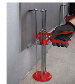
Aretace obkladu bez narušení podkladu – hydroizolační vrstvy
