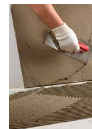
Obr. 13 – Lepení metodou buttering-floating
