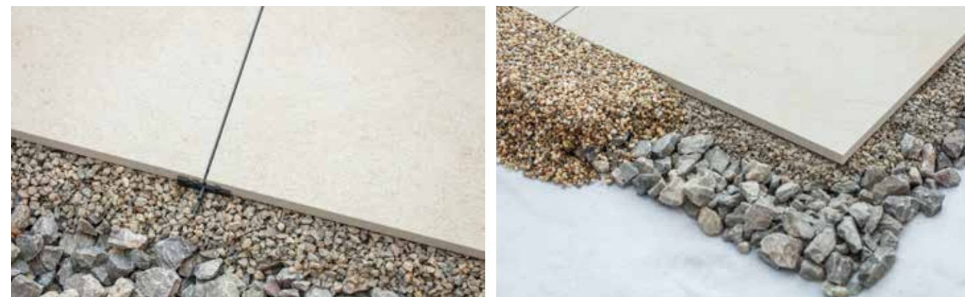
Obr. 22 a 23 - pokládka do štěrku
