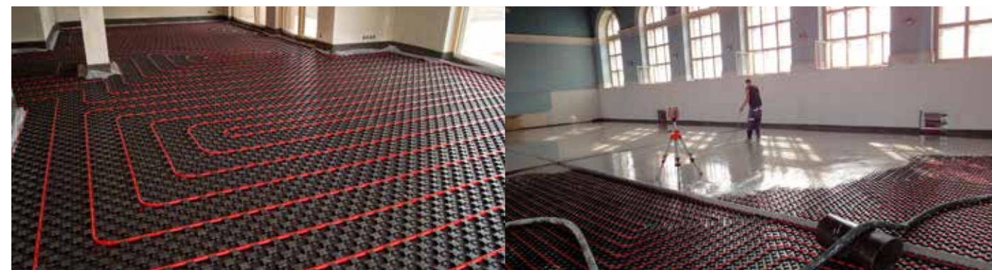
Obr. 16 – Příklad provedení teplovodního podlahového vytápění – mokrý způsob
