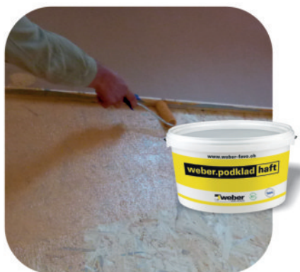
1 penetrace OSB desky weber.podklad haft
