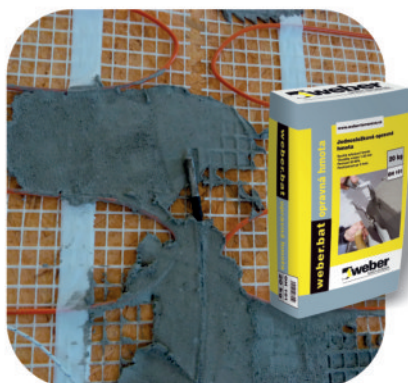
3 položení topných rohoží Fenix pomocí opravné hmoty weber.bat opravná hmota
