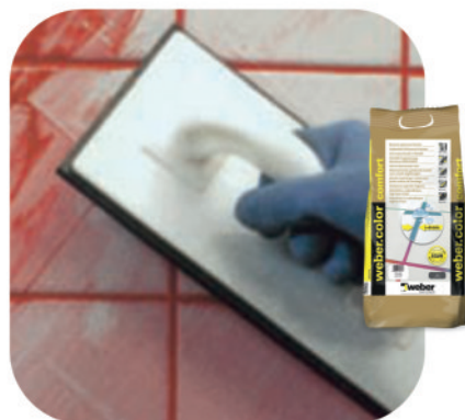
8 zaspárování dlažby spárovací maltou weber.color comfort
