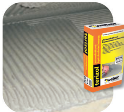
6 nanesení cementové hydroizolační stěrky Terizol
