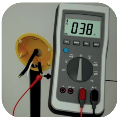
12 kontrola měření odporu topného okruhu
