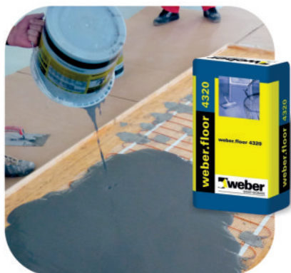
4 zalití rohoží samonivelační cementovou hmotou s vlákny weber.floor 4320
